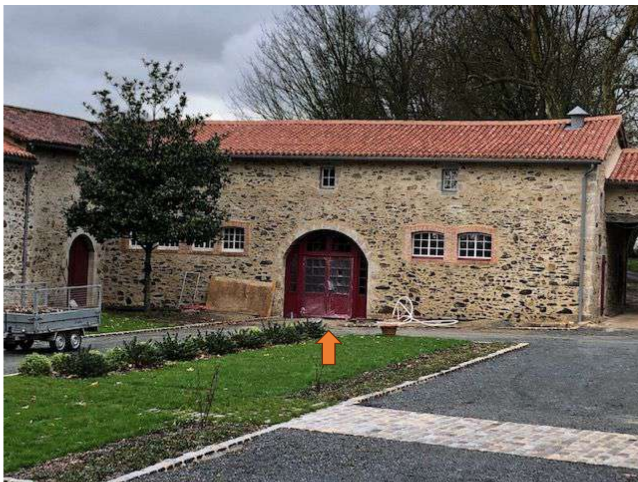
Façade Ouest sur cours (entrée principale de la salle)
